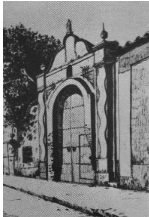
Puerta del Hospital de San Lázaro
